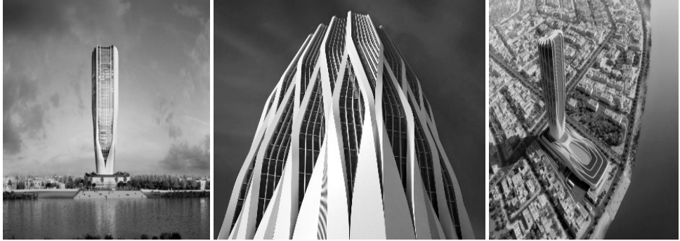
شكل (5): مناظر متنوعة لمبنى البنك المركزي العراقي في بغداد .
